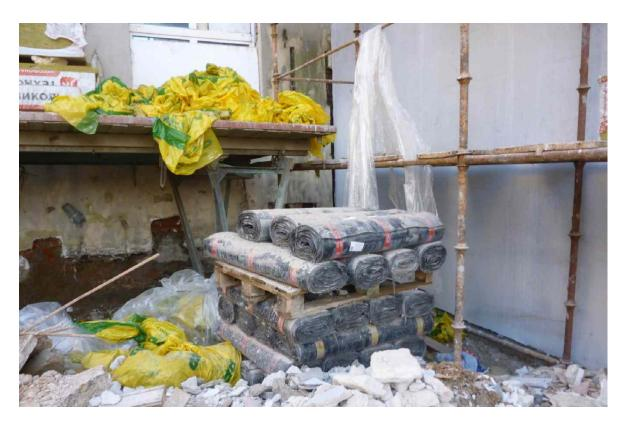
Причиной несчастного случая стала низкая организация производства строительно-монтажных работ с использованием грузоподъемного крана, а именно: допуск к строповке грузов работников, не прошедших обучения по профессии «стропальщик», нарушение проекта производства работ в части установленного порядка строповки и перемещения грузов (на поддоне без ограждения), отсутствие на объекте
