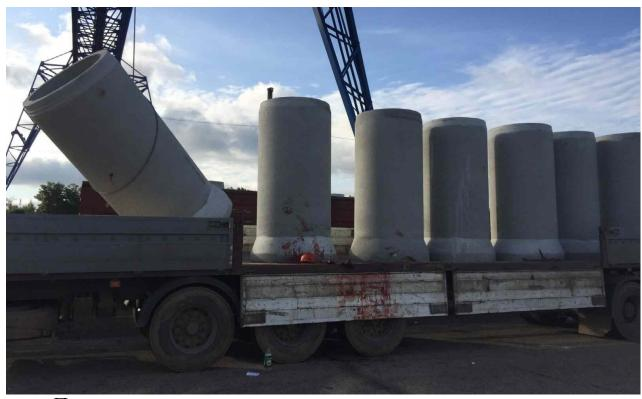
Причинами несчастного случая стали определение лицом, ответственным за безопасное производство работ краном, неправильного железобетонной строповки (небезопасного) способа трубы, исключающего необходимость выравнивания груза вручную при его транспортного средства, а также нарушения установке кузов крана стропальщиком требований инструкций машинистом И безопасному ведению работ.
